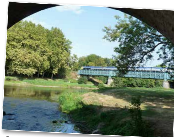
Passage du TER sur le pont de l'Arroux à Étang
