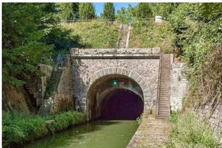
Entrée du tunnel de Pouilly-en-Auxois. Photo Service Patrimoine et inventaire – Région Bourgogne.
