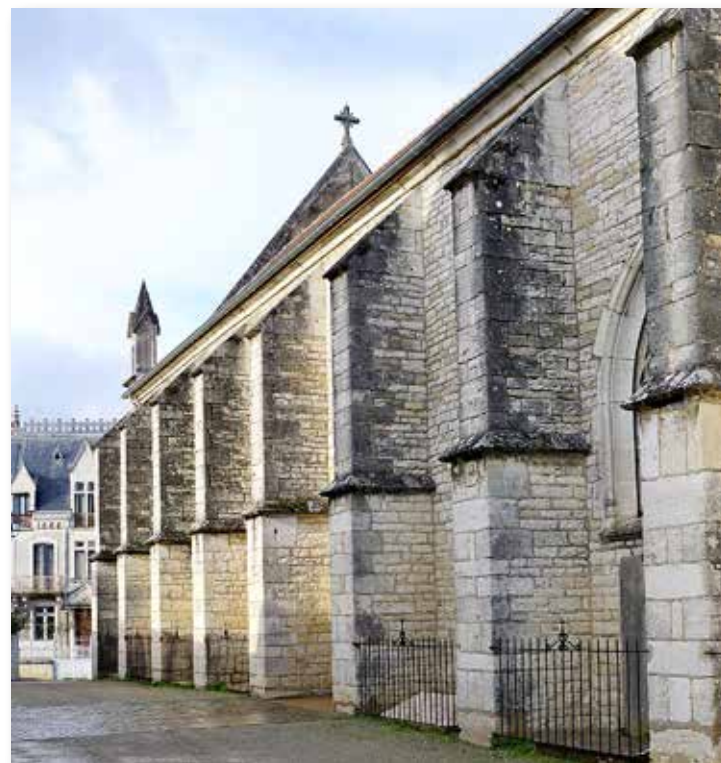
Le mur sud de l'église avec son alignement de contreforts montre la qualité du travail. Photo de l'auteur.
