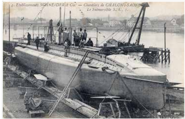
Un sous-marin de type SC1 en place sur les rampes.
