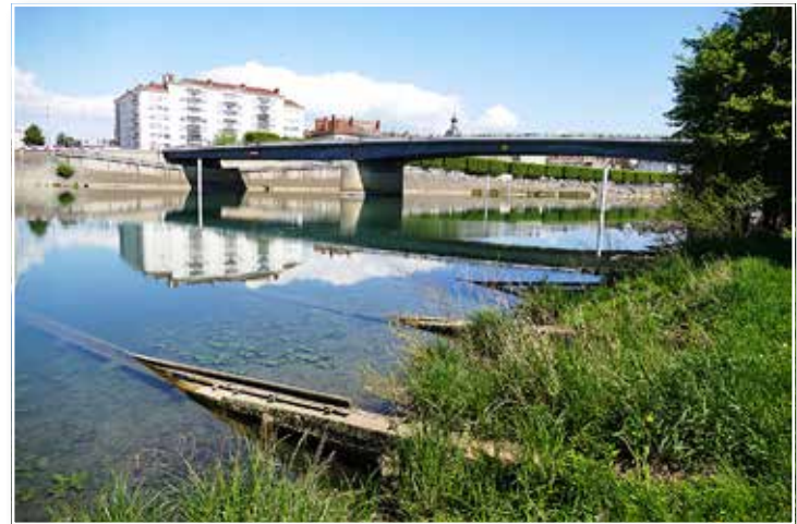
Mai 2021 : les vestiges des rails de lancement au pied du nouveau pont Jean-Richard.
