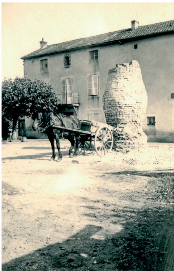
Le four lors de sa démolition, dans les premières années de la guerre. Les parements en pierre ont disparu, rendant visible le four proprement dit, cylindre vertical renflé fait de briques réfractaires.
