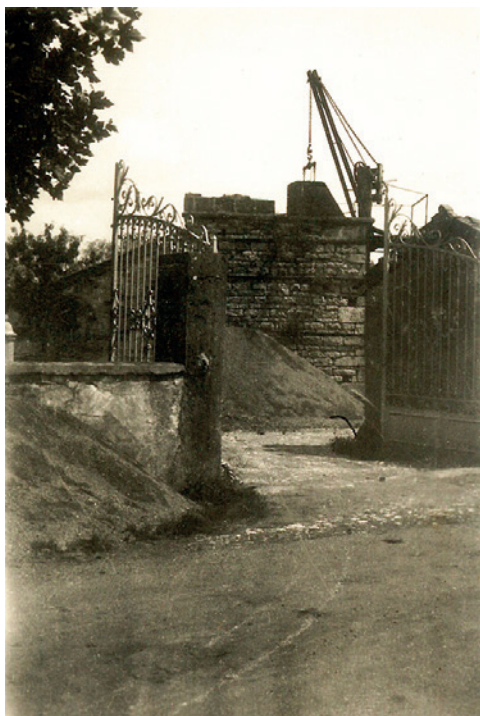
Le four à chaux, construction cubique bâtie au centre de la cour de la maison de la famille Lafarge. Le chargement du four s'effectue à l'aide d'une grue.
