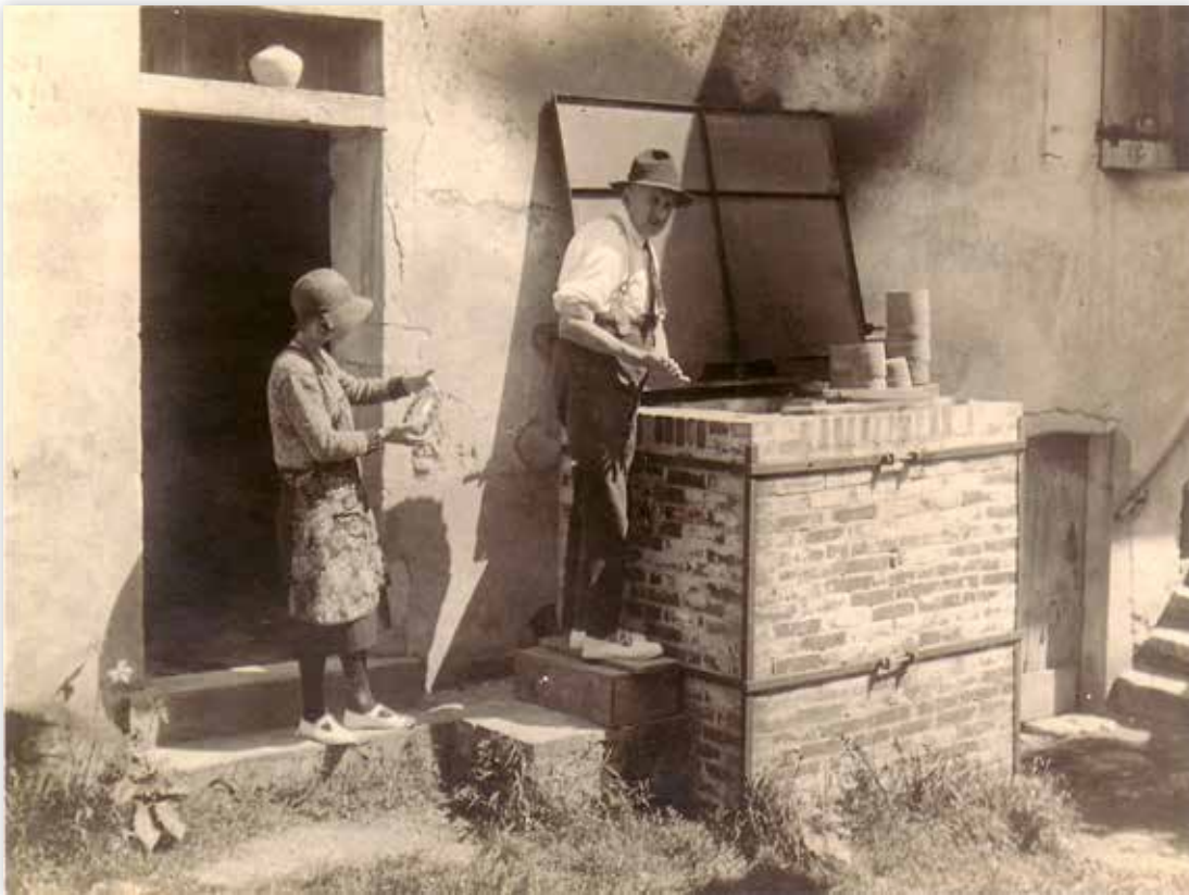
Gabriel Jeandet procédant à un enfournement, devant son atelier de la rue Néronde. Le four, fait de briques réfractaires et renforcé par une solide armature de métal, est celui qu'il a construit de ses mains en 1926.
