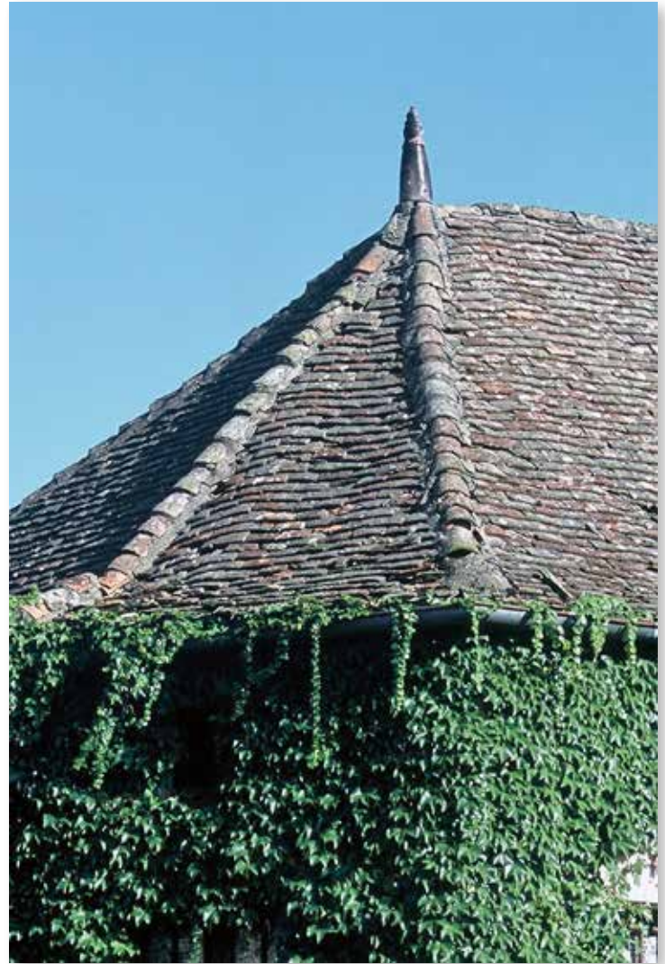
L'épi de faitage qui, il y a quelques années encore, était visible au sommet du toit de la petite maison qui abritait l'atelier de l'artiste. Photo Franck Poidevin.
